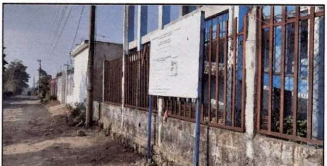
Foto 6: Muro perimetral del establecimiento
