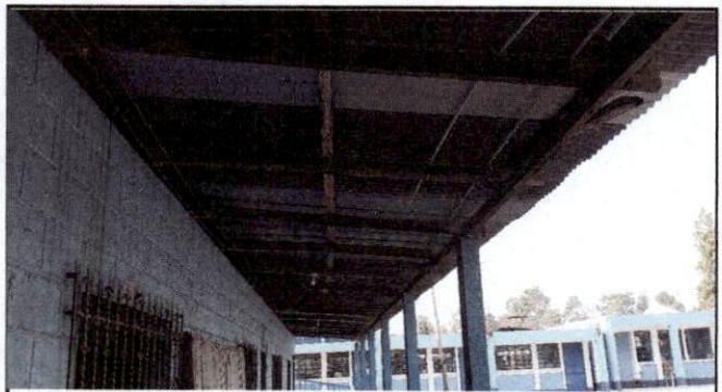
Foto 4: Corredor de las 3 aulas descritas anteriormente
